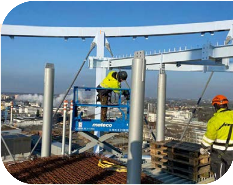
Bei der Montage des Stahlbaus für das Restaurant auf dem Dach des Energie- und Zukunftsspeichers.
