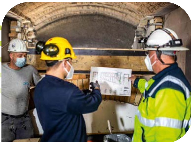
Abstimmungsgespräch im Gewölbe der Feuerbox bei der Revision des Holz-Heizkraftwerks.
