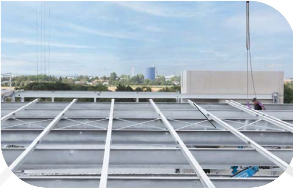
Blick vom Dach des entstehenden Parkhauses auf den Energie und Zukunftsspeicher.
