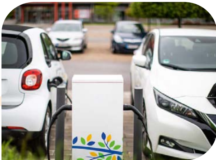
Im Jahr 2021 haben wir zahlreiche weitere Ladesäulen in Heidelberg und der Region installiert – so wie hier in Nussloch.
