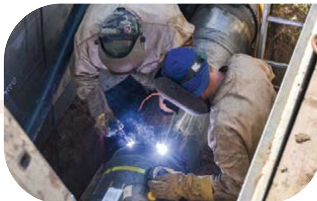
Herausfordernde Arbeiten an einer Gashochdruckleitung: Zwei Schweißer – Fachkräfte der ausführenden Baufirma – arbeiten synchron über mehrere Stunden am Verschweißen eines neuen Teilstücks.
