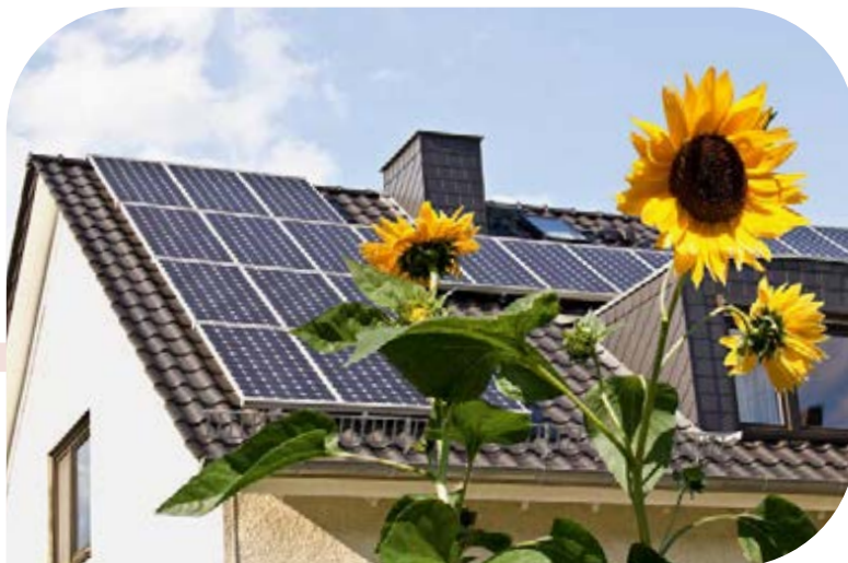
Für eine optimale Steuerung des Stromsystems sind Photovoltaikanlagen mit intelligenten Messsystemen auszustatten.
