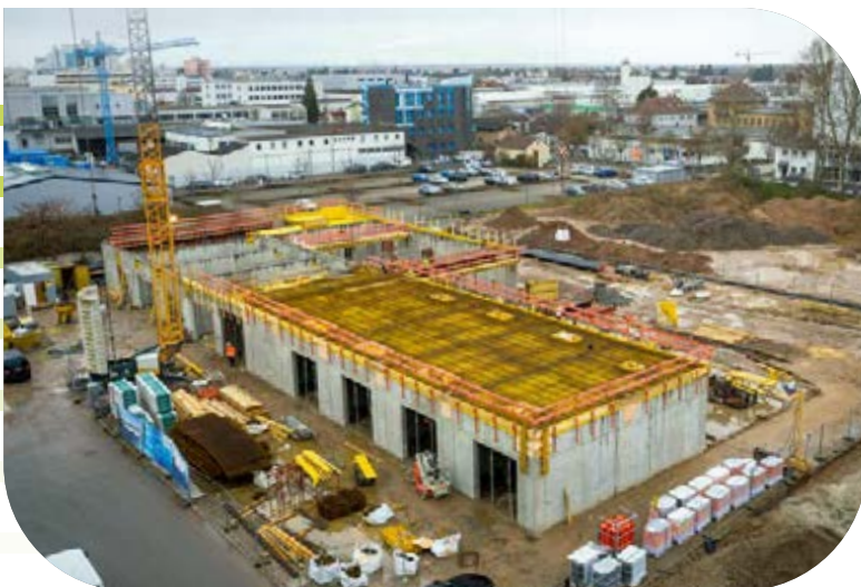
Das Technikgebäude für die iKWK-Anlage entsteht (Stand: Anfang Februar 2022).
