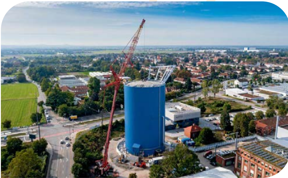
Im Laufe des Jahres 2021 nahm der Bau des Energie- und Zukunftsspeichers auch nach außen sichtbar wieder deutlich an Fahrt auf. Zu Beginn des Jahres hatten Lieferengpässe zu Verzögerungen geführt.
