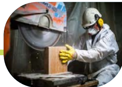
Die Steine für die Ausmauerung der Feuerbox werden geschnitten.
