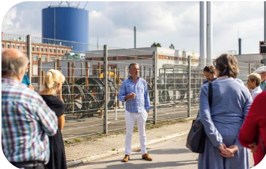
Zu den Tagen der Energiewende im September 2021 konnten wir erstmals wieder Führungen im ENERGIEpark Pfaffengrund anbieten. Im Hintergrund: der Energie- und Zukunftsspeicher mit der entstehenden Krone.
