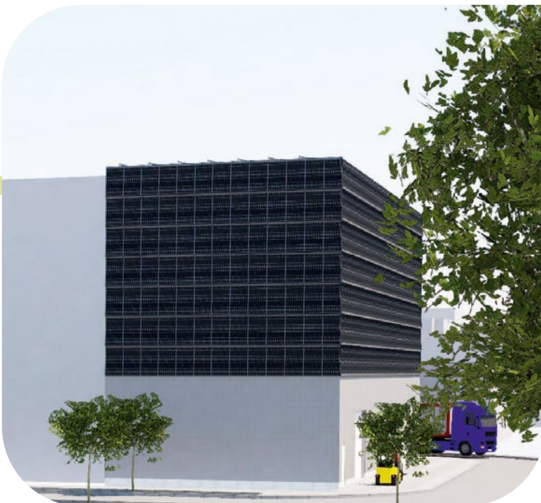
So wird die geplante Kälteanlage in Heidelberg-Bahnstadt, Einsteinstraße, beim Europaplatz aussehen – unser erstes Gebäude mit einer umlaufenden Photovoltaik-Fassade
