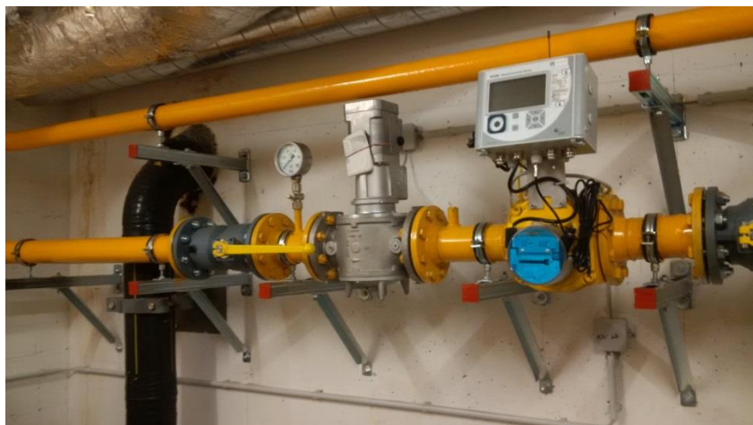
Abbildung 5.3 - Drehkolbenzähler mit Registrierender Lastgangmessung
