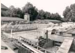
Während der Bauarbeiten im Juli und August 1982.
