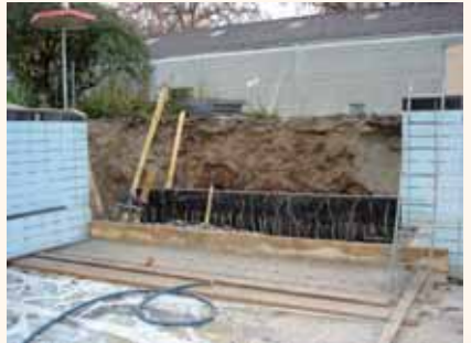
Aushub für den behindertengerechten Beckenzugang.
