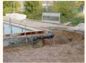
Der freigelegte alte Beckenkopf.
